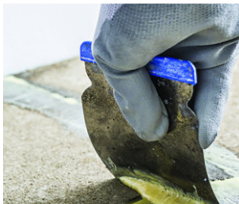
Gleichmässiges Verteilen des Produktes zum Füllen des Risses
