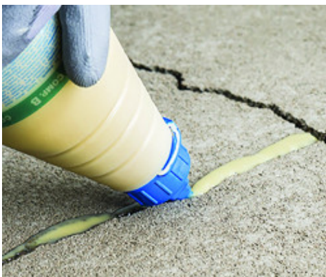
Einfüllen des Produktes in den Riss mithilfe der Tülle
